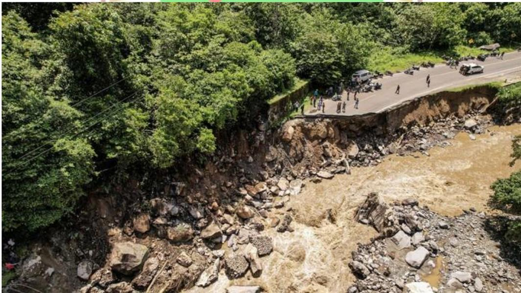
**Gambar 1. 1** Foto udara kondisi jalan nasional yang putus di Kawasan Silaiang, Tanah Datar, Sumatera Barat (Pool, 2024)
