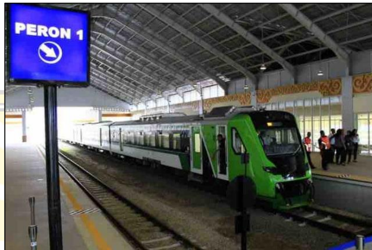
Gambar 1.6 Stasiun Kereta Api Bandara Internasional Minangkabau
