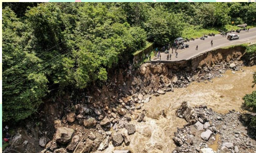
Gambar 1. 1 Foto udara kondisi jalan nasional yang putus di Kawasan Silaiang, Tanah Datar Sumatera Barat
