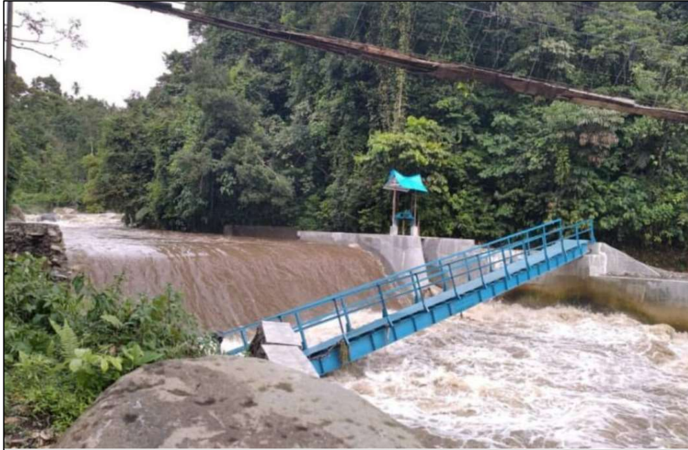
Gambar 1.1 Runtuhnya bendung DI Anai Sasapan
