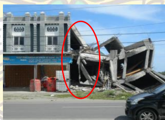
Gambar 1.3 Kerusakan bangunan di Indonesia akibat benturan pounding karena tidak adanya ruang pemisah (sumber : Chairunnisa F.A 2022)
