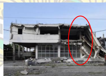
Gambar 1.3 Kerusakan bangunan di Indonesia akibat benturan pounding karena tidak adanya ruang pemisah (sumber : Chairunnisa F.A 2022)
