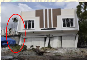
Gambar 1.3 Kerusakan bangunan di Indonesia akibat benturan pounding karena tidak adanya ruang pemisah (sumber : Chairunnisa F.A 2022)
