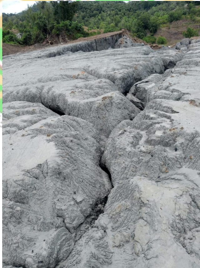
Gambar L.3. Kondisi Permukaan Lokasi Penimbunan FABA Pada Lahan Bekas Tambang di Kota Sawahlunto Setelah Hujan
