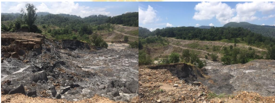
Gambar 4.1. Longsor Area Penimbunan FABA di Kota Sawahlunto
