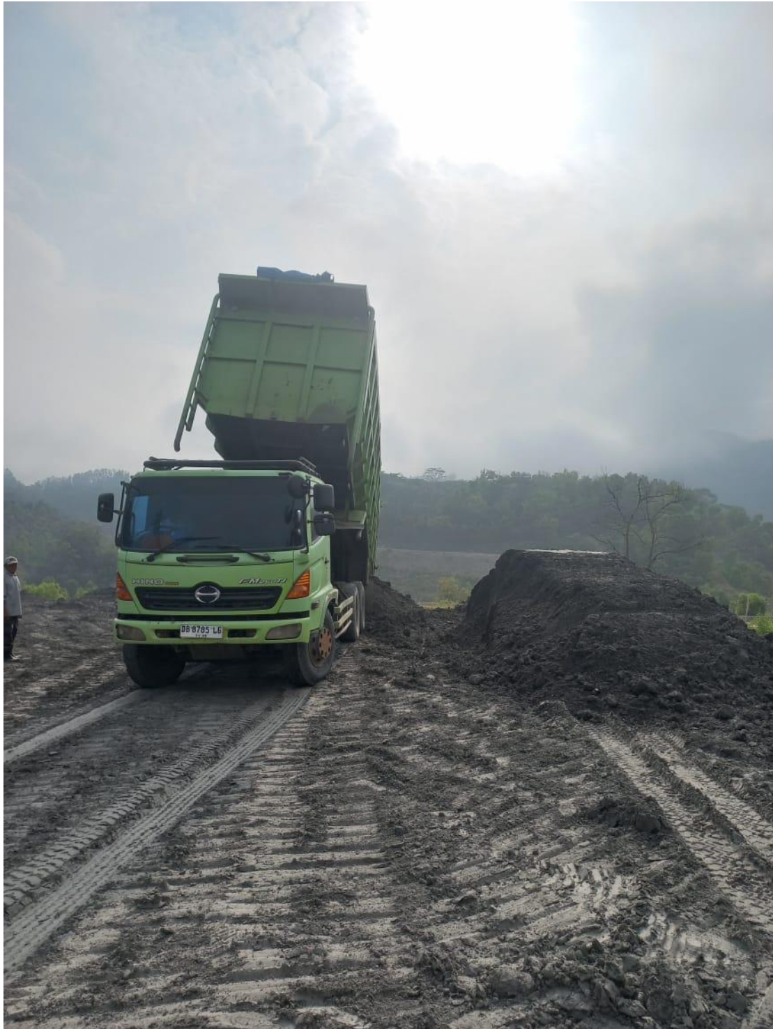
Gambar L.1. Kondisi Operasional Penimbunan FABA ke Lahan Bekas Tambang di Kota Sawahlunto
