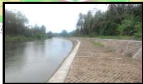
Gambar 4.3 Arah Barat Bangunan Pengendali Banjir Sungai Batang Nareh
