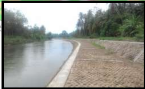
Dok. Arah Barat Bangunan Pengendali Banjir Sungai Batang Nareh
