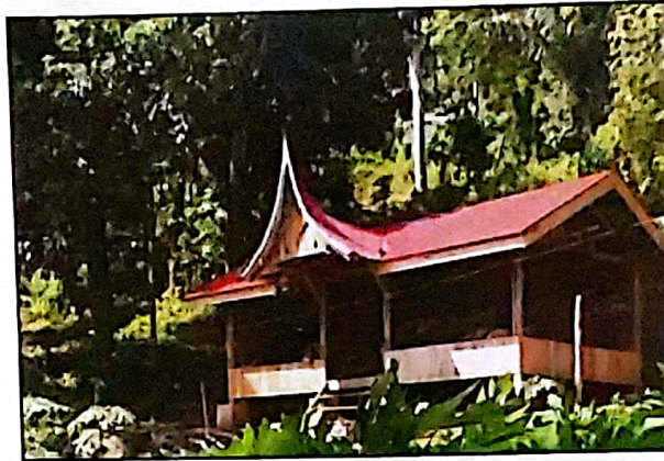
Gambar 4.3 Pembangunan Rumah Serbaguna
