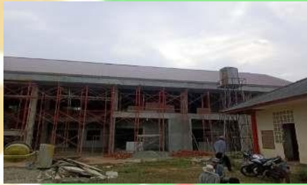
Tampak Depan Rusun Batalyon B Satuan Brimob Polda Bengkulu
