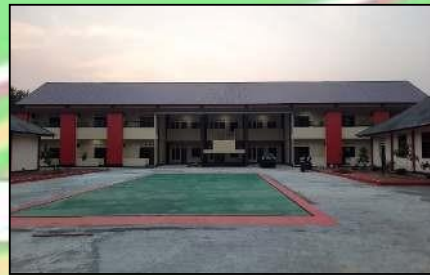
Tampak Depan 100 % Pembangunan Rumah Susun Batalyon B Satuan Brimob Polda Bengkulu
