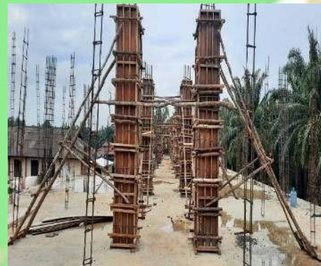
Pemasangan Bekisting Kolom Struktur lantai Dua
