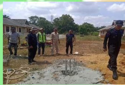
Pelaksanaan Pengecooran Pondasi Boor Fail
