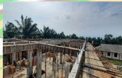
Pemasangan Bekisting Plat Cantilever Elevasi + 700 cm
