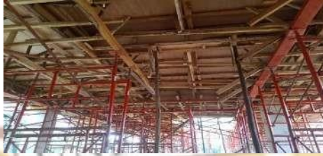
Pemasangan Bekistin Balk Dan Plat Lantai Dua
