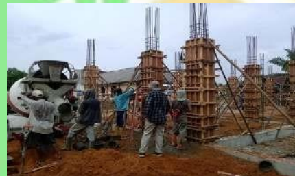
Pengecooran Kolom Struktur Beton Mutu K 250 memakai Beton Ready Mix
