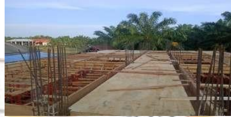
Pemasangan Bekistin Balk Dan Plat Lantai Dua
