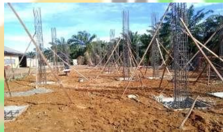
Pemasangan Kolom Struktur Lantai Satu
