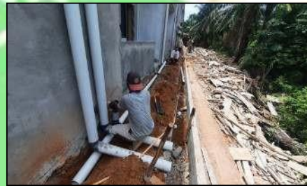
Pekerjaan Pemasangan Instalasi Pipa Air Kotor
