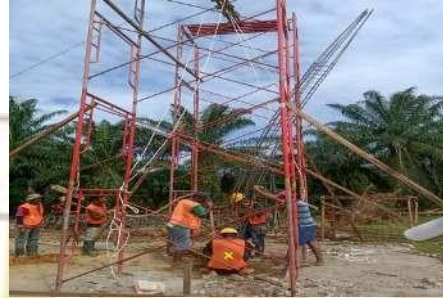
Pelaksanaan Kolom Pondasi Dalam Pada Lobang Yg Sudah Di Boor Fail
