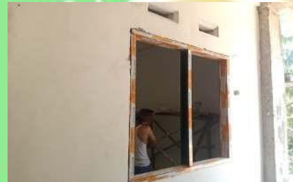
Tampak Bagian Dalam Rusun Batalyon B Satuan Brimob Polda Bengkulu
