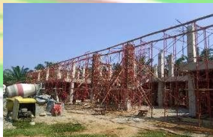
Pemasangan Bekisting Balk Elevasi +750 cm
