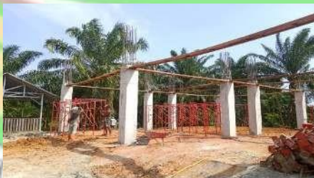
Pemasangan Bekisting Balk Lantai Dua
