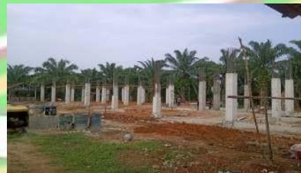
Pemasangan Bekisting Balk Lantai Dua
