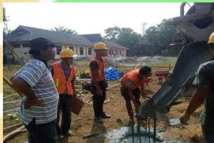
Pelaksanaan Pengecooran Pondasi Boor Fail
