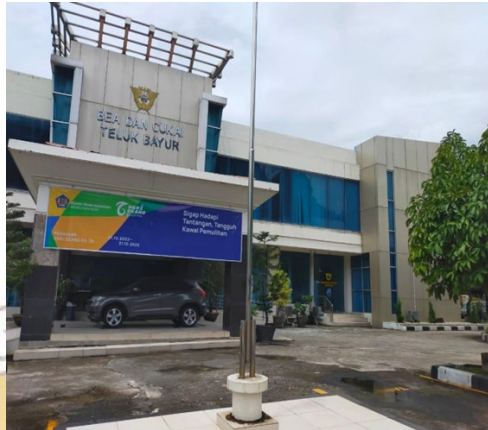
Gambar 1.1 Bangunan kantor Pengawasan dan Pelayanan Bea dan Cukai Teluk Bayur
