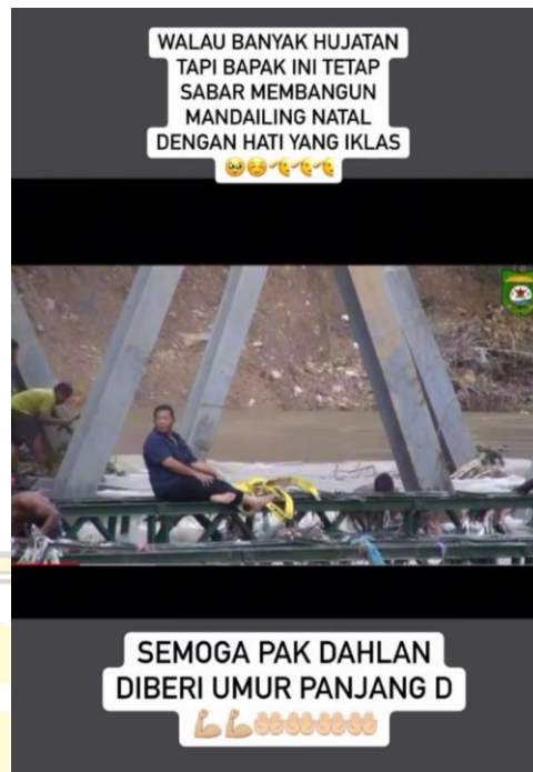
Gambar 5.2 Pembangunan Jembatan Di Kecamatan Muara Batang Gadis dan Pembangunan Jembatan Di Kecamatan Tambangan 115
