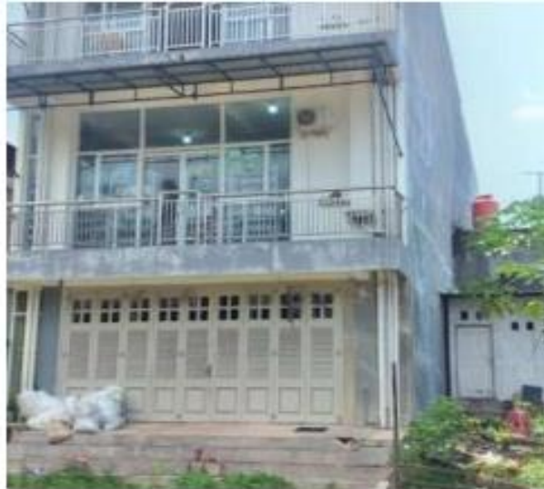
Gambar 1.4 Bangunan Tanpa IMB/PBG
