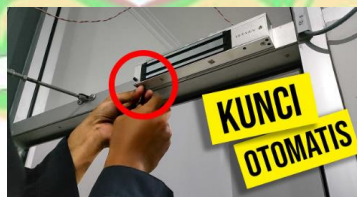
Gambar 2. 29 Pemasangan Kunci Elektromagnetik Tanpa Perombakan [52]
