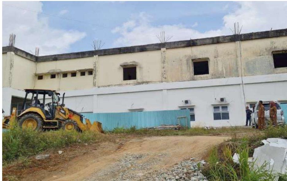
Gambar 5.10 Kondisi Kantor Bupati Kerinci di Bukit Tengah
