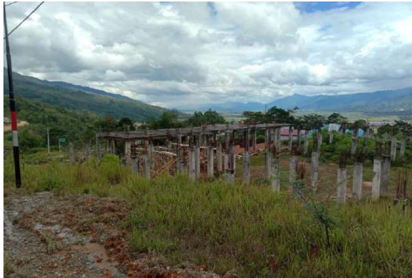
Gambar 5.6 Pembangunan Gedung DPRD Kab.Kerinci
