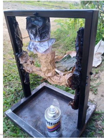
Pengecatan kerangka utama
