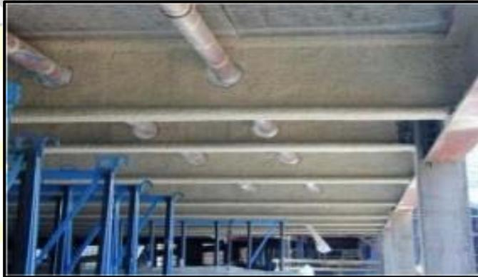
**Gambar 1.2. Pemasangan Instalasi dengan Bukaan pada Balok (Jabbar et al., 2021)**
