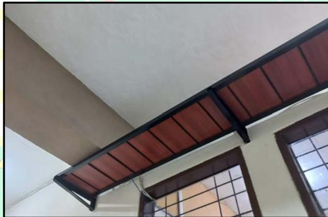
**Gambar 1.1. Pemasangan Instalasi Tanpa Bukaan pada Balok**
