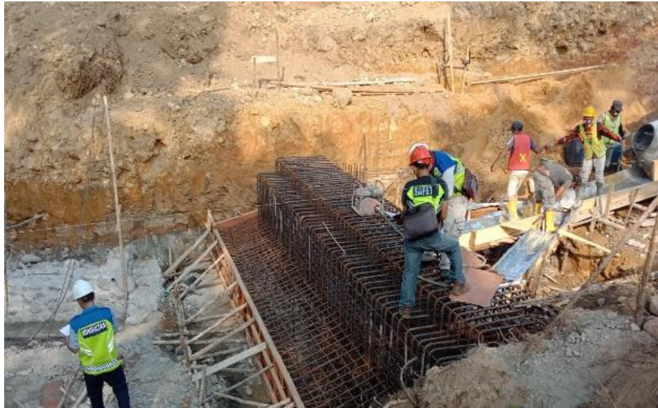
Gambar 9. Proses Supervisi Pekerjaan
