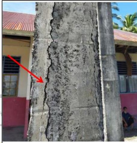
**Gambar 1.1** Retak Split pada Permukaan Kolom
