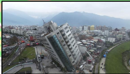
Gambar 1.1 Kerusakan gedung akibat gempa
