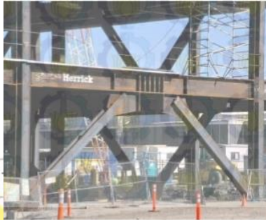
Gambar 1.1 Sistem Struktur Rangka Baja dengan SRBE (Sistem Rangka Bresing Eksentris)
