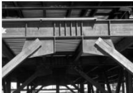
Gambar 1.1 Struktur Baja Sistem Rangka Bresing Eksentris
