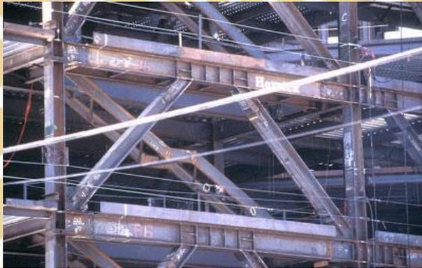
**Gambar 1.1** Struktur Rangka Bresing Eksentris
