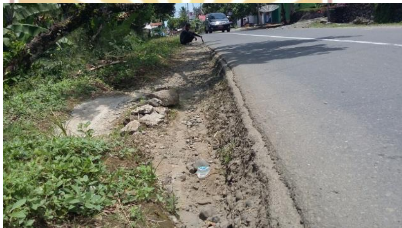
Gambar 3.34 Kondisi Bahu Jalan di STA 6+000
