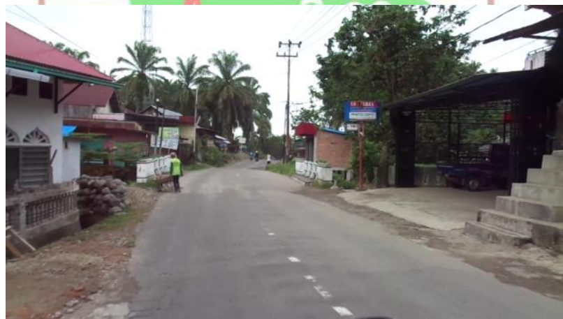
Gambar 3.45 Jembatan 1(pertama) tanpa pagar keselamatan
