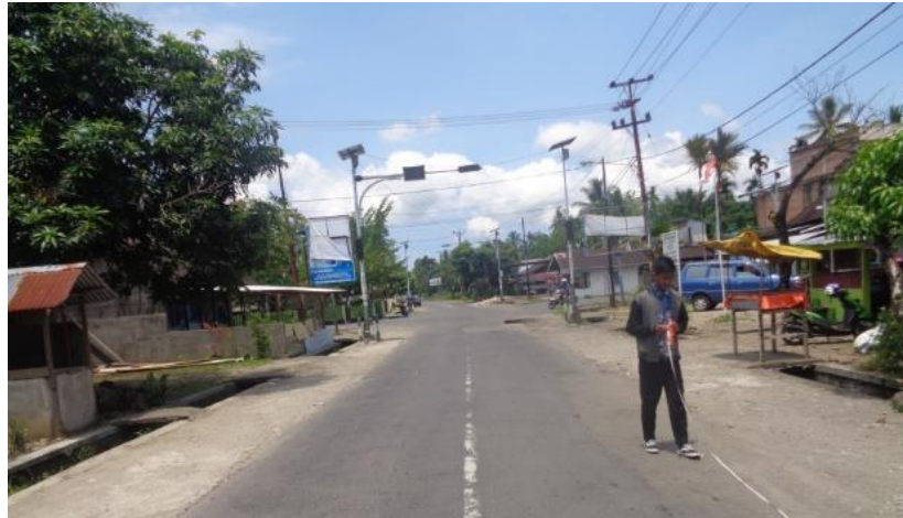
Gambar 3.43 Lampu pengatur lalu lintas di STA 5+000 yang tidak berfungsi.
