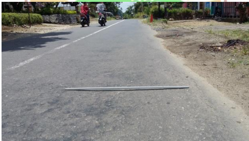
Gambar 3.5 Corrugation (Bergelombang) (5L)
