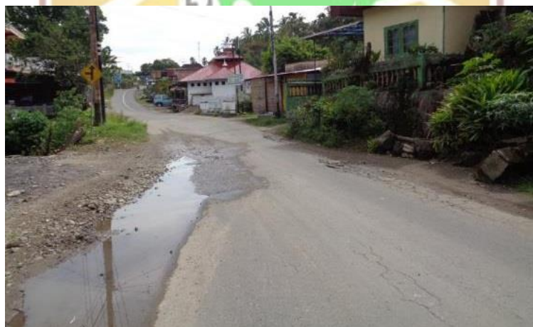
Gambar 3.47 Adanya Genangan Air di STA 0+000
