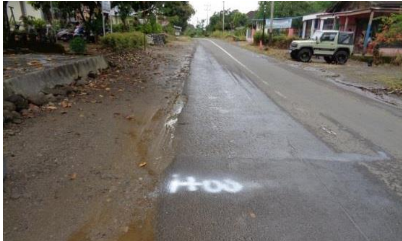
Gambar 3.35 Jalan tanpa Drainase di STA 1+000
