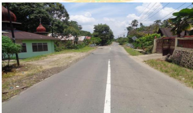
Gambar 3.46 Jembatan 2 (kedua) tanpa pagar keselamatan
