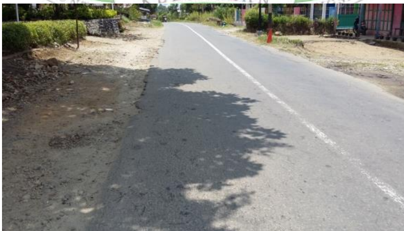
Gambar 3.3 Weathering/Revelling (Butiran Lepas) (19L)
