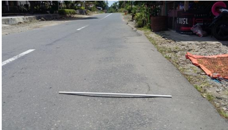
Gambar 3.1 Rutting/Alur (15M)
