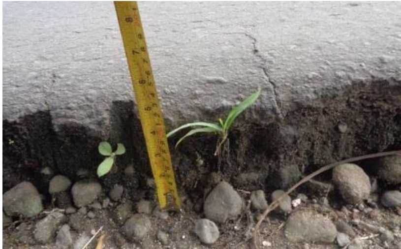
Gambar 3.33 Kondisi Bahu Jalan di STA 1+000
