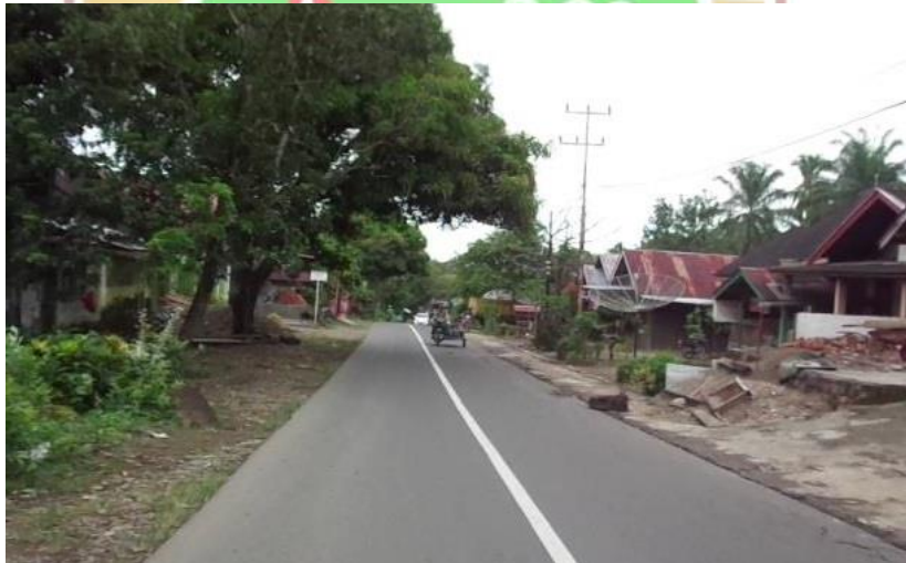
Gambar 3.36 Tanaman/Pohon di Pinggir yang Mengganggu Jarak Pandang
