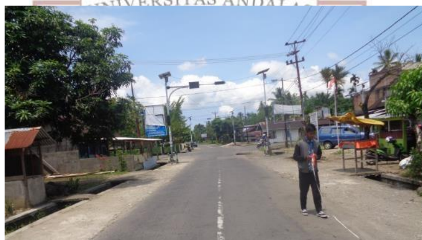
Gambar 3.41 Tidak ada rambu dan marka pada lokasi penyeberangan pejalan kaki di STA 5+000
