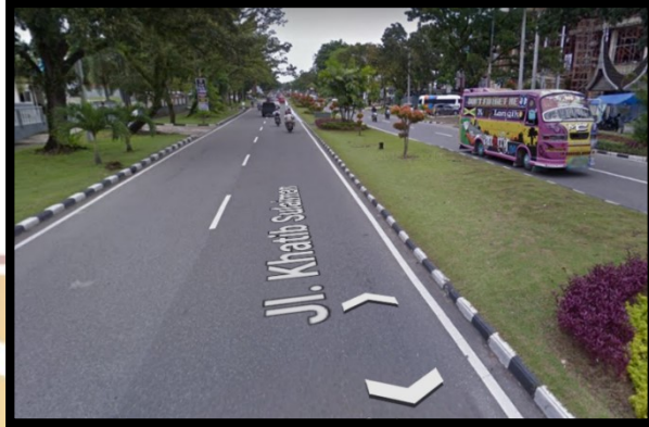
Gambar 1.2. Kondisi jalan Khatib Sulaiman sebelum dilakukannya peningkatan jalan
