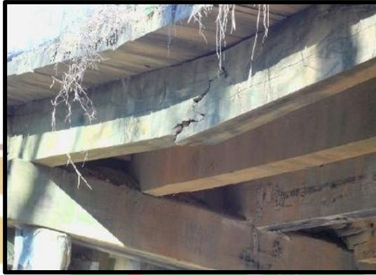
**Gambar 1. 1** Balok girder jembatan yang mengalami keruntuhan geser.
