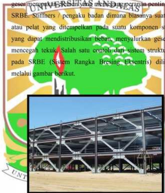
**Gambar 1.1** Sistem struktur baja dengan SRBE
