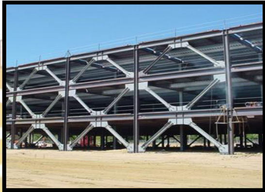
Gambar 1.1 Contoh struktur baja dengan Sistem Rangka Bresing Eksentris (SRBE)
