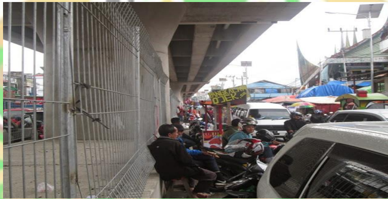
Gambar 1.2 Pangkalan Ojek Liar di Bawah Jembatan Fly Over Kota Bukittinggi
