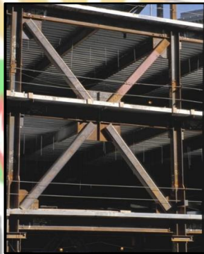
Gambar 1.2 Struktur Rangka Bresing Eksentris
