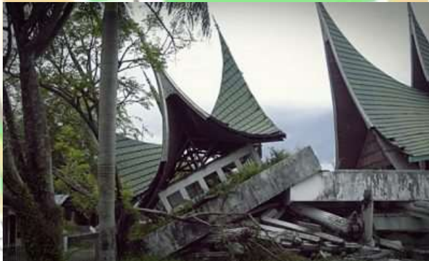
Gambar 1.1 Kerusakan Gedung Akibat Gempa
