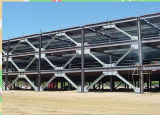
Gambar 1.1 Contoh struktur baja dengan Sistem Rangka Bresing Ekesentris (SRBE)
