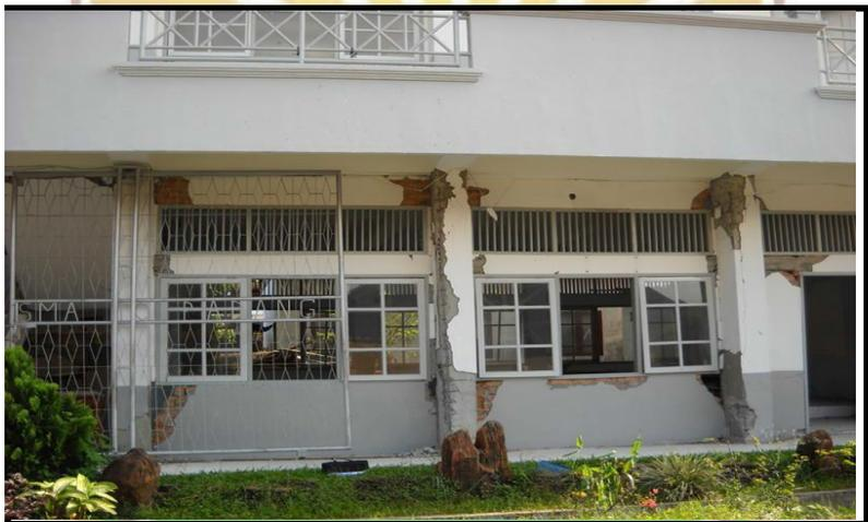
**Gambar 1.2 Kondisi Bangunan Yang Mengalami Rehabilitasi Infrastruktur Fisik Pasca Gempa Bumi**
