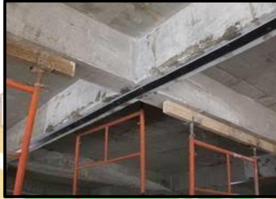
Gambar 1.2 Pemasangan CFRP Plate Pada Balok
