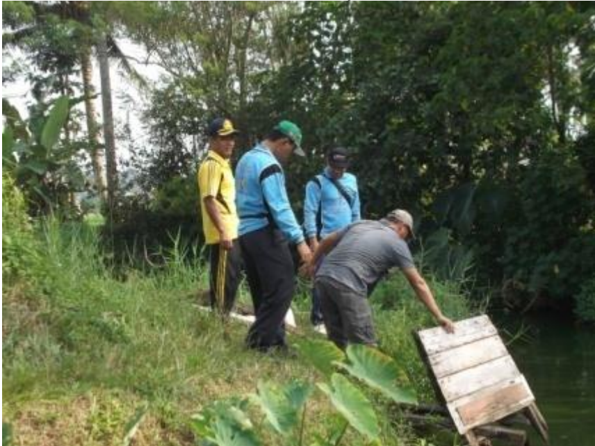
Gambar 1.1. Pembongkaran Jamban yang Tidak Saniter oleh Pemerintah Kota Payakumbuh dengan Masyarakat
