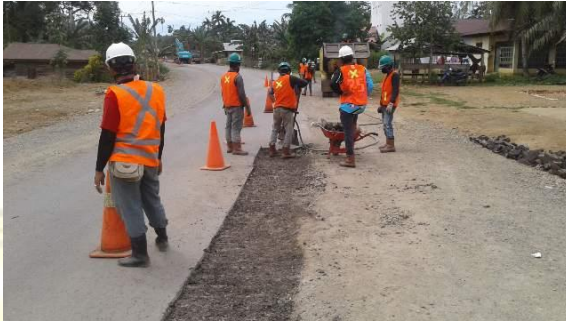
Gambar 1. 1 Proses Pengambilan RAP di Jalan Lintas Painan
