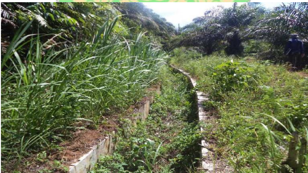
Gambar 1.1 Kondisi Saluran Sekunder DI. Batang Gumarang
