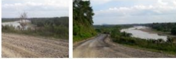
Pembangunan berupa pengaspalan jalan dan Pemberian koral penghubung Kec. Lumpen, Kec. Situng dan Kec. Pulau Punjung.
