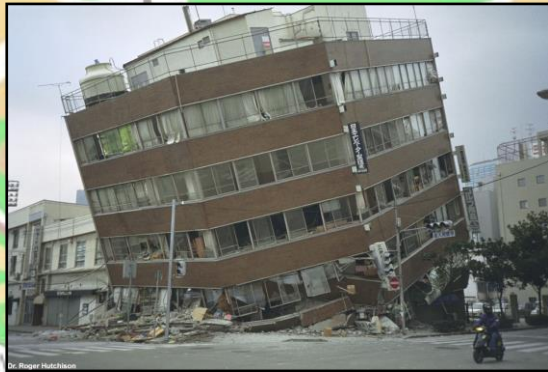
Gambar 1.1 Kerusakan Gedung Akibat Gempa
