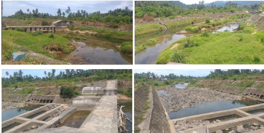
Gambar 1.7 Check dam titik P.68 (Sumber : Dokumentasi Pribadi)
