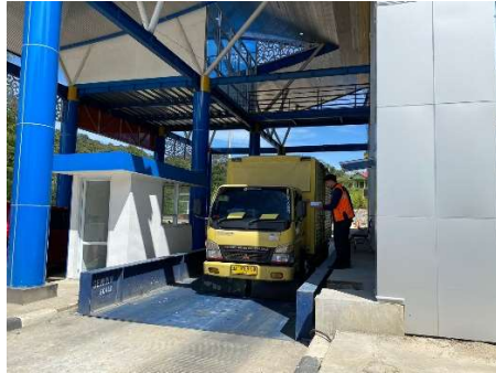
Gambar 1. 3 Jembatan Timbang UPPKB Lubuk Selasih
