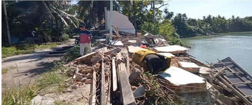
Gambar 1.2 Kondisi DAS Batang Anai di Korong Talao Mundam
