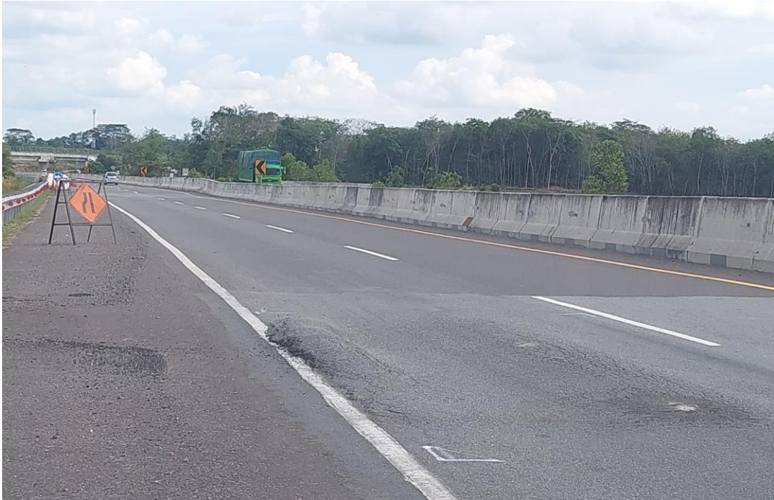
Gambar 1.1 Contoh Kerusakan Deformasi
