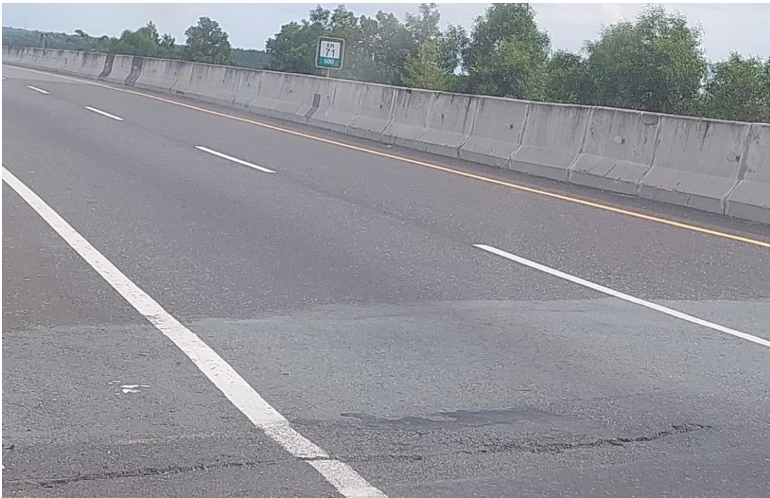
Gambar 1.2 Contoh Kerusakan Retak
