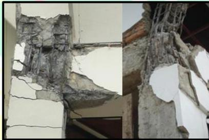
**Gambar 1.2** Kegagalan akibat tidak adanya tulangan sengkang pada balok kolom *joint* beton bertulang pada Gedung Samsat Provinsi Sumbar. (sumber : <http://www.wm-site.com/civil-eng/short-course-haki-komda-bali-2010>)
