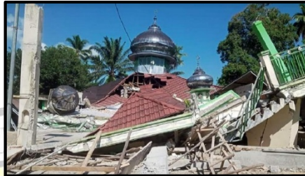
Gambar 1.1 Kerusakan Akibat Gempa Bumi di Pasaman Barat
