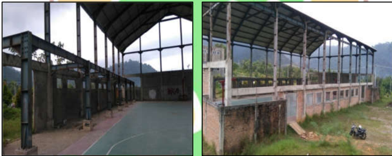
Gambar 1.1 Kondisi Eksisting Bangunan
