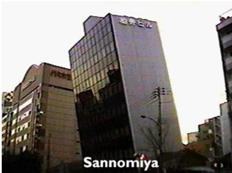
**Gambar 2.6** Gedung perkantoran di Jepang yang miring akibat tanah terlikuifaksi
