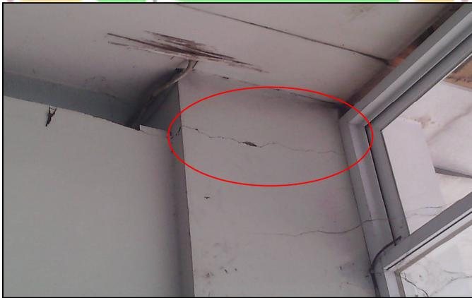
**Gambar 1.3** Kondisi Retak Pada Kolom
