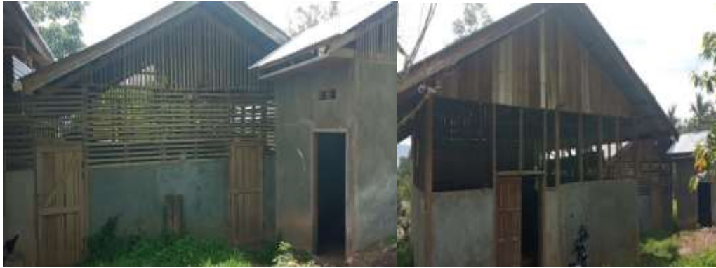
Gambar 4. Bangunan Kandang Komunal dan Rumah Kompos Kelompok Tani Sawah Rambahan
