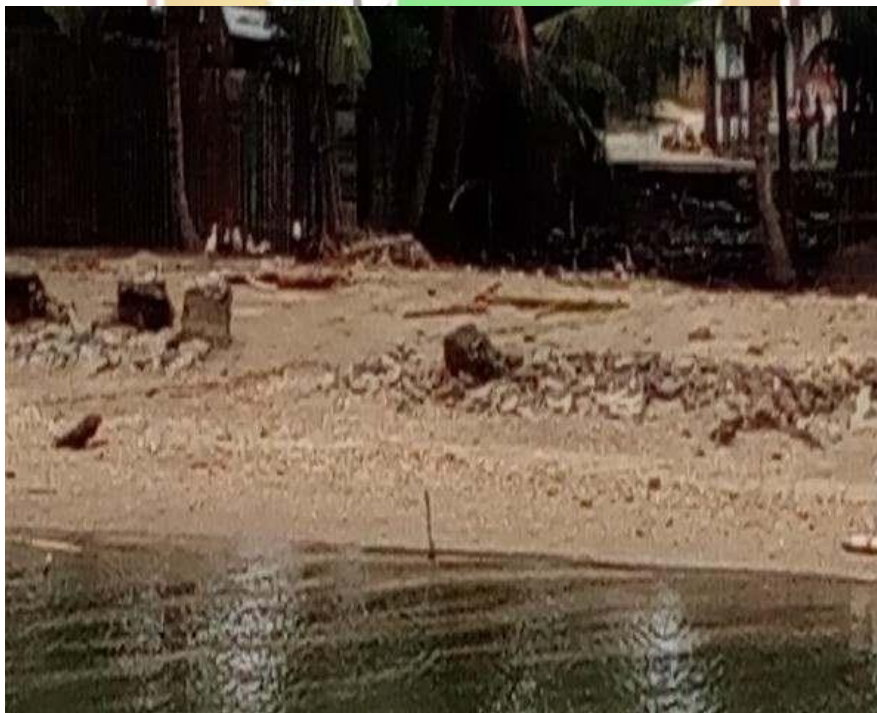
Hasil Kerusakan Daerah PesisirPantai akibat abrasi
