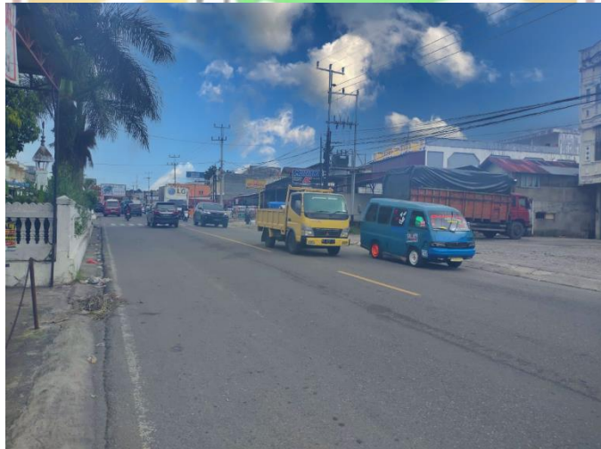
Gambar 1.2 Lokasi Survei Ruas Jalan Raya Padang Lua Kecamatan Banuhampu Kabupaten Agam
